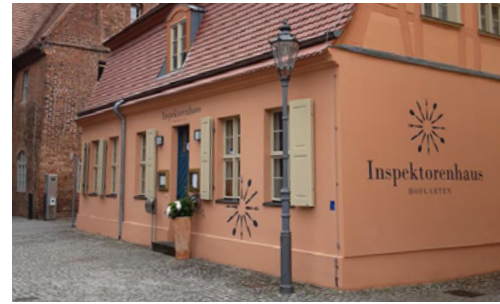
Inspektorenhaus Brandenburg an der Havel
